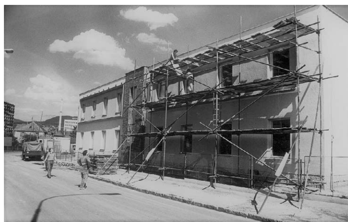
Na historickém snímku stavba správní budovy našeho družstva. Foto Miloš Konrády
