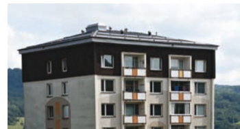
Pohled na novou střechu našeho domu.
