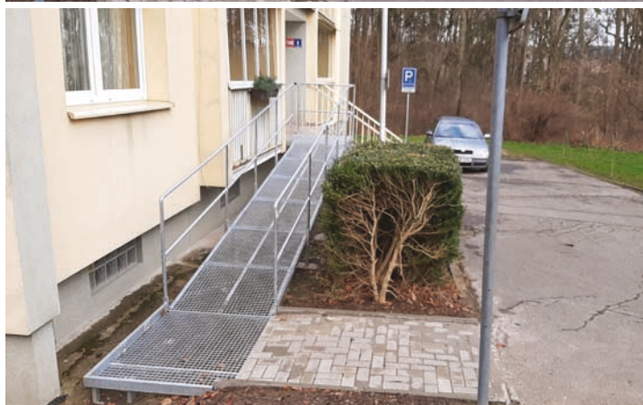
Pohled na nově zbudovanou nájezdovou plošinu.
