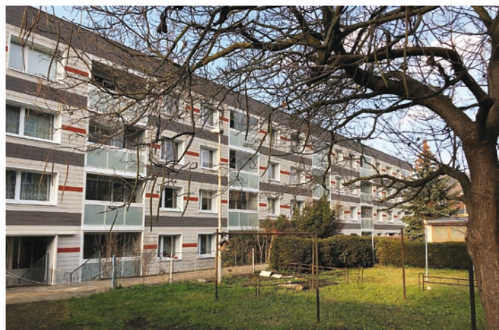
Celkový pohled na dům SVJ Riegrova 1342-1344 v Děčíně II
