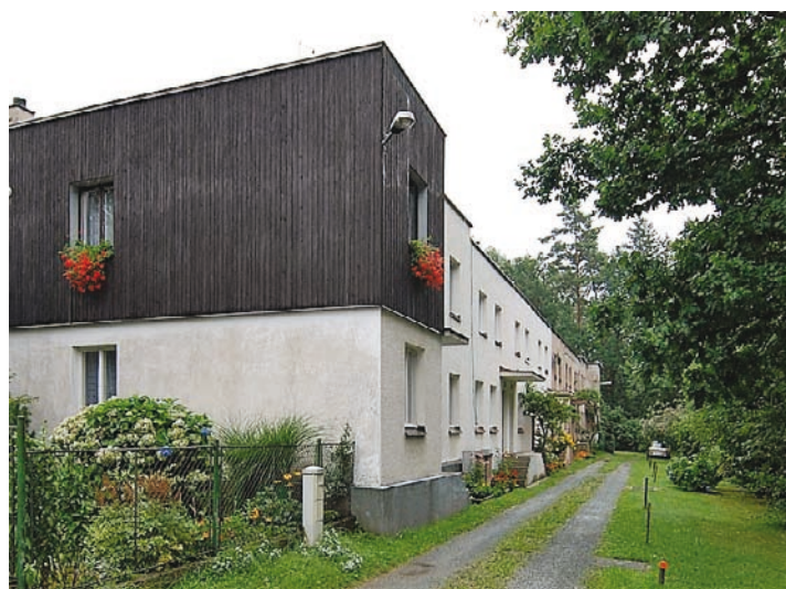
Kolonie rodinných dělnických domků Adolfa Loose. Pět jednopatrových řadových domků. Fasády jsou hladké ze škrábaného okrového břizolitu, dole se soklem. Ke každému vchodu je pět stupňů a nad tím rovná stříška. Průčelí má rytmus, ve kterém se střídají vchody a okna. V zadních částech rodinných domků jsou východy na zahrádky a zděné kůlny na palivo. Celkem je zde deset bytů bez podsklepení. Postaveno v roce 1931.
