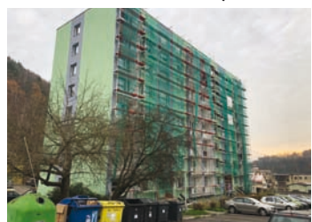
Náročná rekonstrukce SVJ Rudolfova 247, 248 v Děčíně IX se chýlí ke svému závěru.
