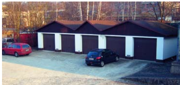
Pohled na garáže na dvoře SBD Děčín v Zelené ulici, Děčín III.
