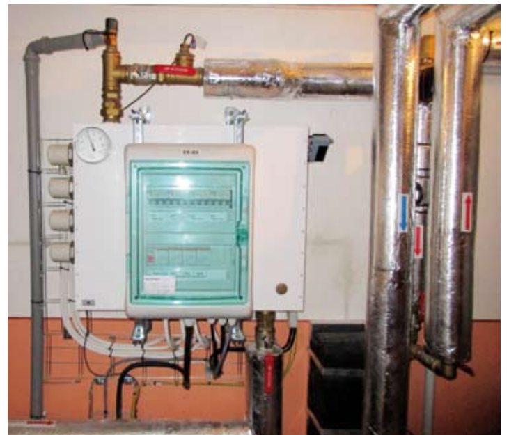
Pohled na část technologie tepelného čerpadla v jedné z nevyužitých místností v suterénu domu.
