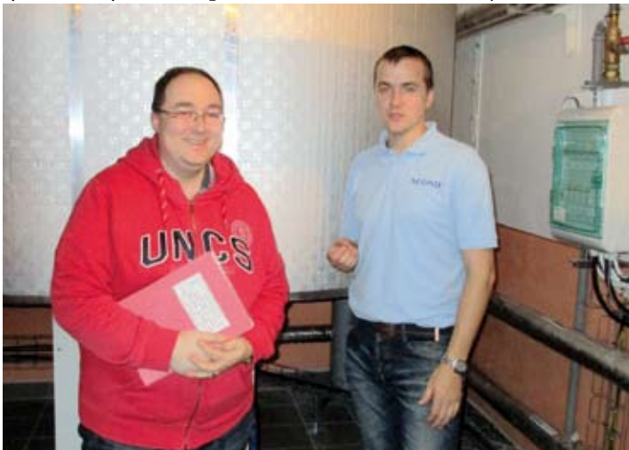
Vlevo předseda SVJ Na Valech Ing. Pavel Konopásek, vpravo Ing. Zbyněk Dvořák, zástupce firmy ACOND, a.s. V pozadí vlastní těleso tepelného čerpadla a jeho vzduchotechniky.
