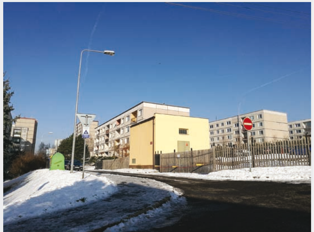
Většinou opravené a zrekonstruované domy, krásné okolí – mohlo by to být klidné místo k bydlení, kdyby... foto: archiv SBD Děčín
