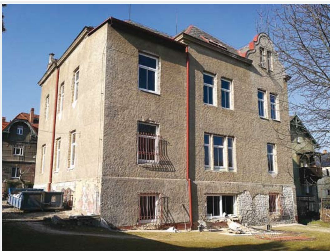
Stav budovy v době těsně po zahájení rozsáhlé rekonstrukce – již s vyměněnými okny.
