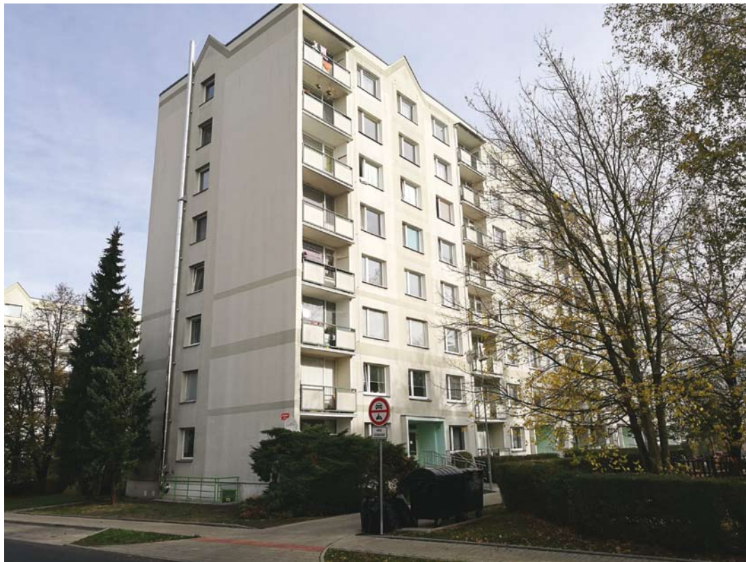
Také Společenství vlastníků jednotek Oblouková 296, 297, 298, 299 na Starém Městě má od konce loňského roku svou vlastní plynovou kotelnu.
