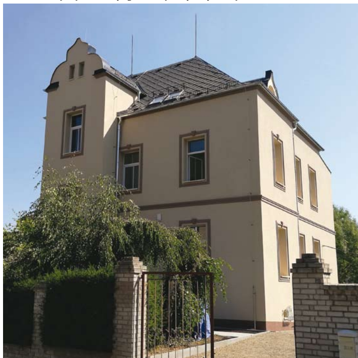
Budova Úřadu rady bytových družstev severočeské oblasti v Alešově ulici v Ústí nad Labem.
