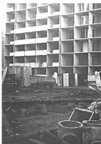
Staveniště a hrubá stavba budoucího družstevního domu Plavební 114 a 115, Děčín I.
