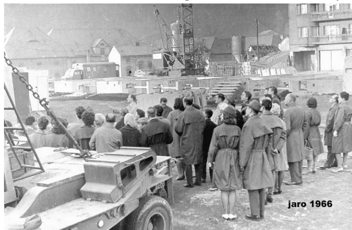
Schůze natěšených družstevníků přímo na staveništi – jaro 1966.
