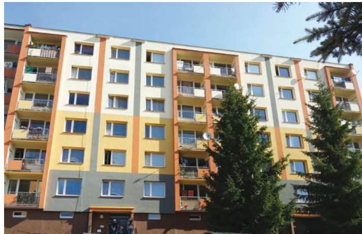
Celkový pohled na dům samosprávy 292 v Děčíně Bynově. Že se o dům někdo dobře stará, je patrné na první pohled.
