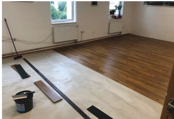
Starý zohýbaný a místy již téměř prodřený koberec byl nahrazen moderní vinylovou krytinou, strop a stěny byly vyběleny, zářivky vyměněny za nové.
