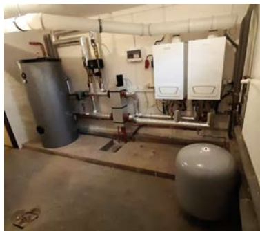
Nová kotelná a vynucené vedení komínu za výtahovou šachtou.
