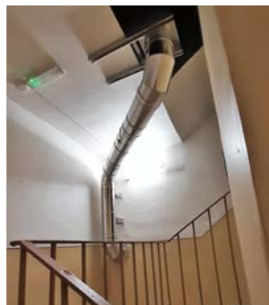
Nová kotelná a vynucené vedení komínu za výtahovou šachtou.
