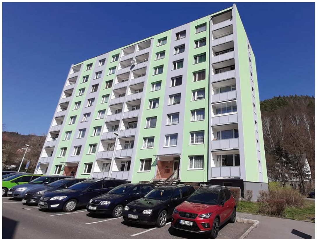
Dnes by rekonstrukce například tohoto domu v Rudolfově ulici stála minimálně o jedenapůl násobek více. O této stavbě jsme psali v minulém čísle Zpravodaje.
