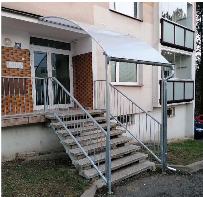
Pohled na zastřešení hlavního vchodu do domu.
